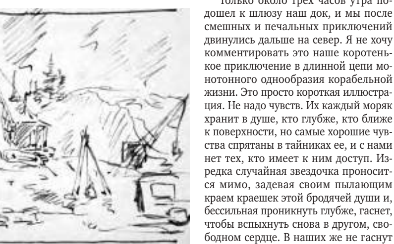
Рис. 29. Строительство новых шлюзов Марининской системы
